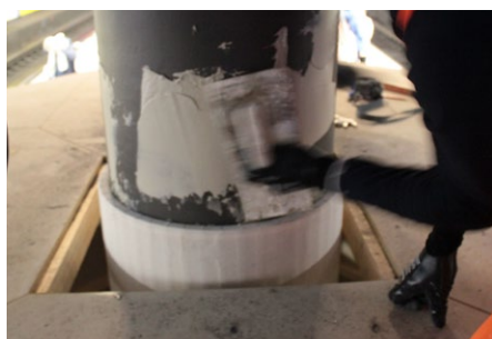
7 Nettoyer l'acier Appliquer uniformément le Promat® Adhesive K84 (é ≥ 1 mm) sur l'acier
